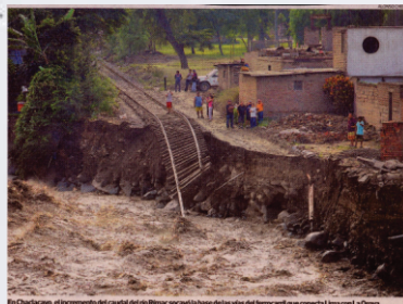
En Chacabuco, el incremento del caudal del río Seco ocasiona la base de las vías del ferrocarril que conecta Lima con La Oroya.
